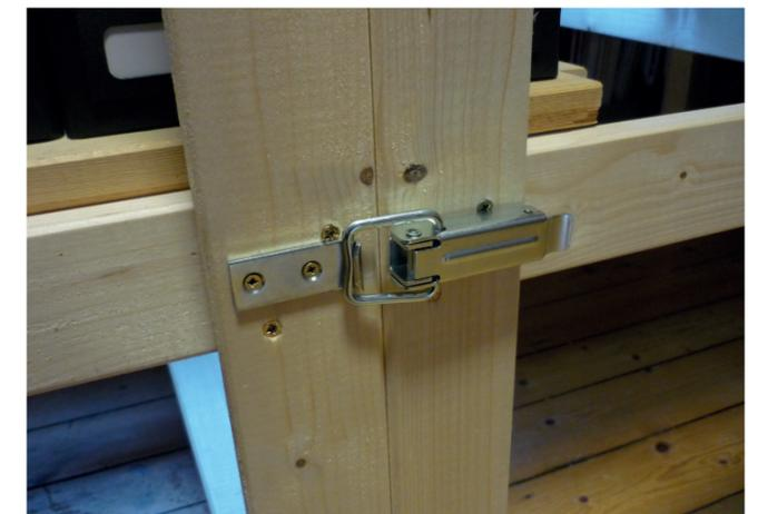
Mehr Halt braucht es an dieser Stelle nicht: Die beiden Rahmenteile wurden durch Schnellverschlüsse sicher miteinander verbunden.
