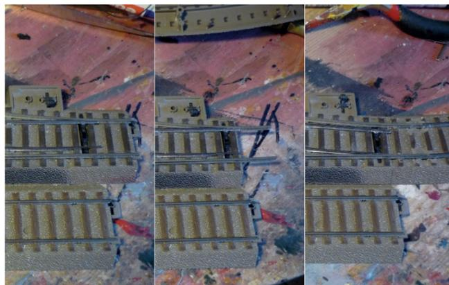
Damit die Weichenverbindung eingebaut werden konnte, musste zunächst eine der Weichen ein Stück eingekürzt werden.
