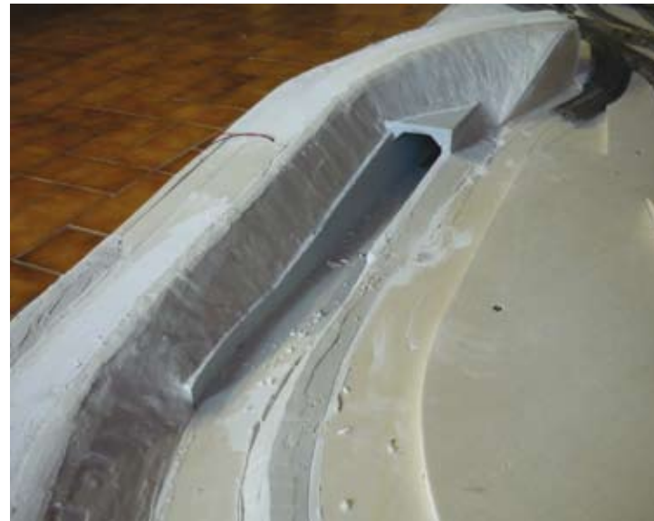
Die mit Moltofill verspachtelte Betonunterführung muss in Ruhe durchtrocknen, bevor sie abgeschliffen werden kann.
